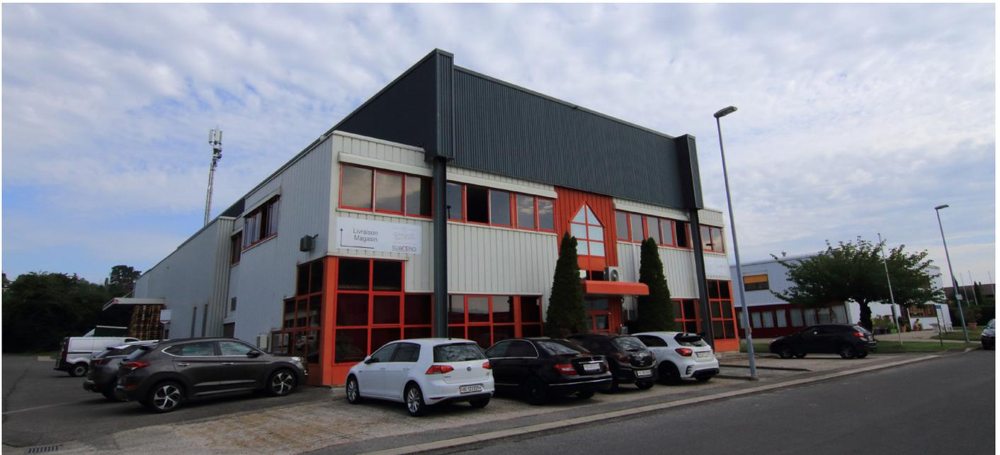
Ce bâtiment industriel de 50 x 23 m de deux étages, pour un volume de 8'800 m<sup>3</sup>, est rehaussé d'un étage de 50 x 15 m, soit 2'600 m<sup>3</sup> supplémentaires.
